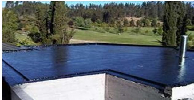
**TREMPROOF 260: Membrana Impermeabilizante de Emulsión asfáltica**
