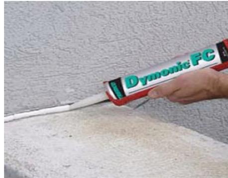
**DYMERIC 240 FC: Sello de Juntas de Dilatación Bicomponente; Marca: TREMCO\*\*\*.**
