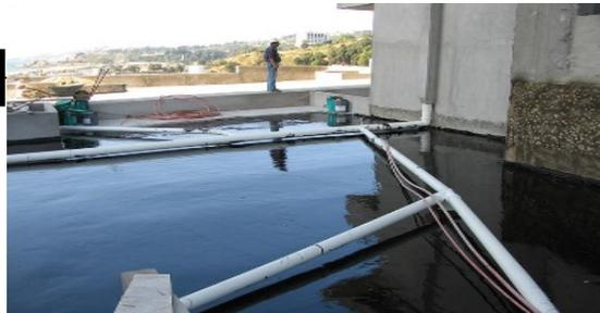
IMPERMEABILIZACION DE PLACAS Y CUBIERTAS
